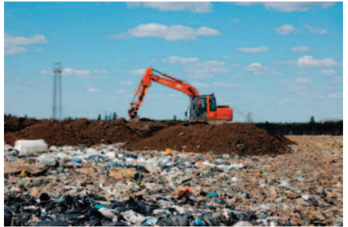
Hapetuskerrokseen käytetyn kompostimullan levittämistä kesällä 2010.
