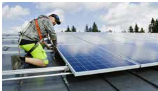
Kymenlaakson Jätteen Sami Korhonen tarkastamassa aurinkopaneelien asennusta.
