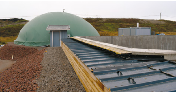
Oikealla mädättämön eli biokaasulaitoksen betoninen reaktoriallas, taustalla kaasukello.
